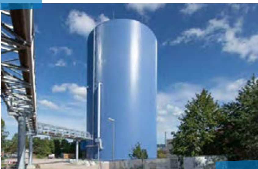
Im Jahr 2019 ging der Bau des Energie- und Zukunftsspeichers voran. Der Technikteil des Gebäudes hat seine finale Höhe erreicht, der Speicher wurde mit Fernwärmewasser befüllt, gedämmt und ans Netz angeschlossen.
