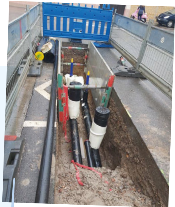
Bei Baumaßnahmen an unseren Kabel- und Rohrleitungen fallen Erdaushub und Straßenaufbruch als Abfälle an.
