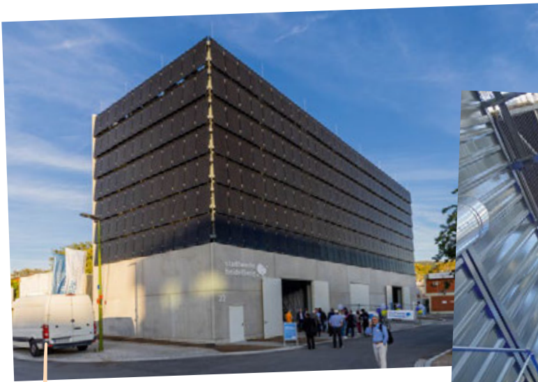
Die Kältezentrale am Europaplatz in Heidelberg-Bahnstadt mit ihrem »Solarhut«.
