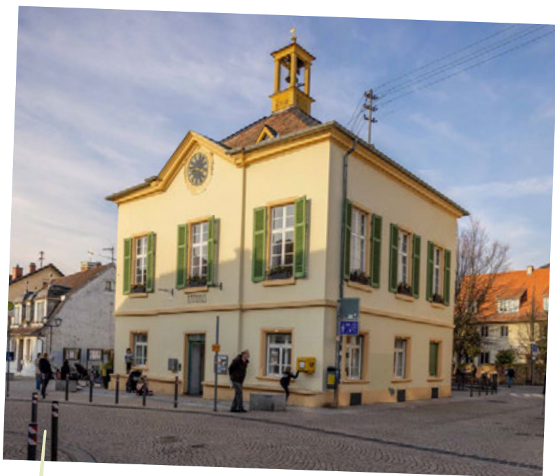
Im Jahr 2023 hat unser Haustechnik-Team unter anderem die Wärmeversorgung des alten Rathauses in Heidelberg-Rohrbach auf Fernwärme umgestellt.
