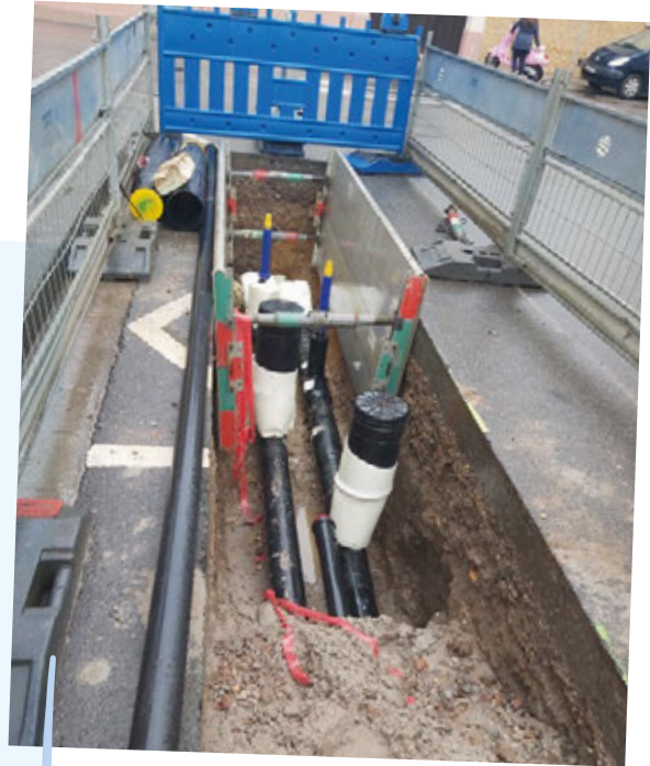
Bei Baumaßnahmen an unseren Kabel- und Rohrleitungen fallen Erdaushub und Straßenaufbruch als Abfälle an.
