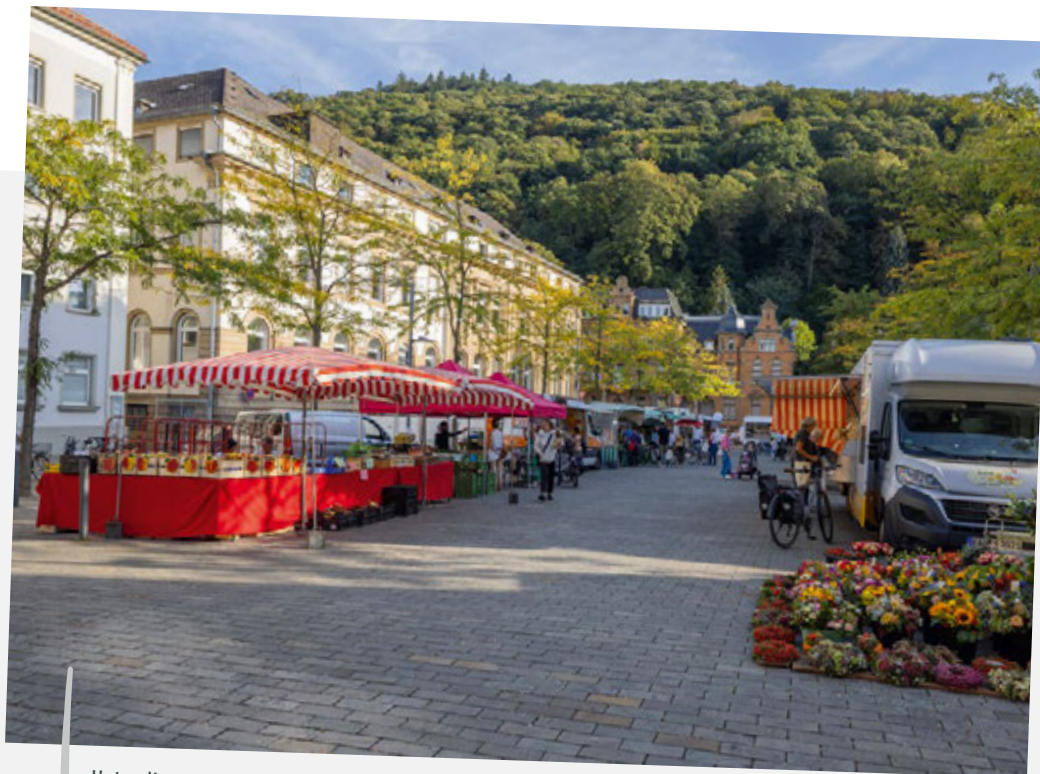
Unter diesem Markt auf dem Friedrich-Ebert-Platz liegt das Parkhaus P10. In einem sechsmonatigen innovativen Projekt wurde im P10 eine korrosionssichere Beschichtung aufgebracht.
