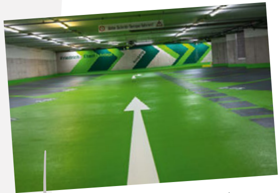
Mit korrosionsfester Beschichtung und klarer Wegeführung: Ebene 2 im Parkhaus Friedrich-Ebert-Platz (P10).
