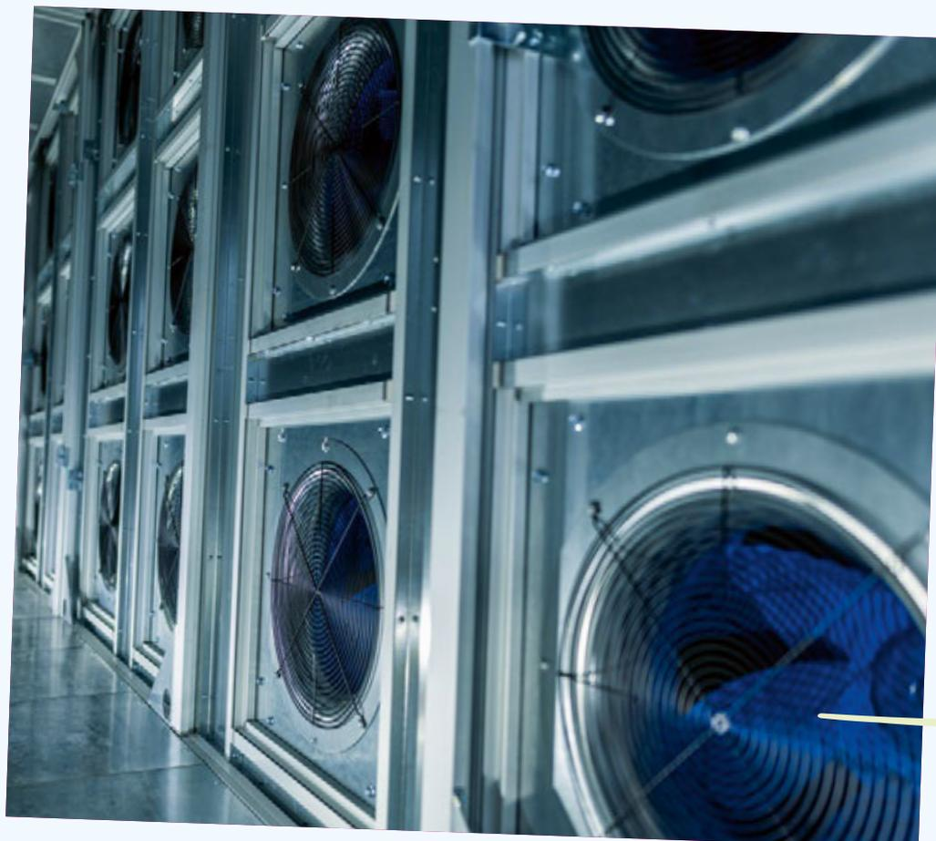
Die Ventilatoren der iKWK-Anlage saugen die Umgebungsluft an, von dort wird sie in den Luftkühler gedrückt. Hier wird ihr die Wärme entzogen.
