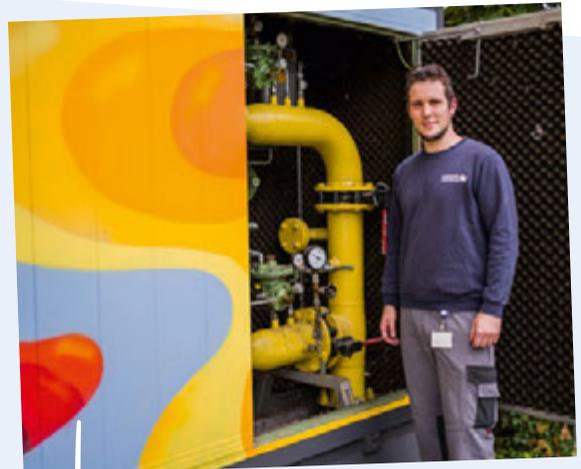
Das Innere des »Kastens«. Hier wird der Gasdruck, der einen zügigen Transport des Gases sichert, für den Einsatz vor Ort reduziert.
