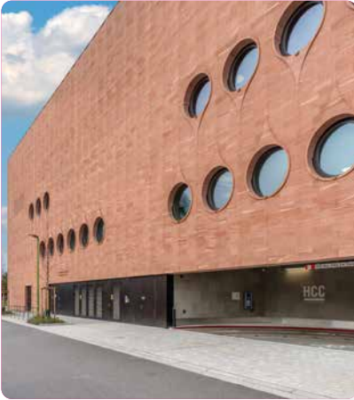
Das neue Parkhaus am Heidelberg Congress Center (P21) in Heidelberg-Bahnstadt: Im März 2024 haben wir den Pachtvertrag unterzeichnet.
