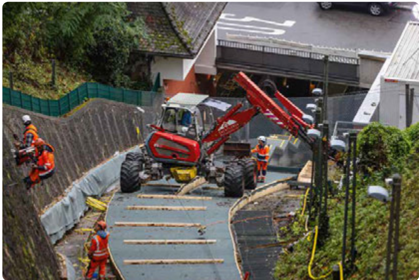
Zwischen Anfang Oktober und Mitte November 2024 wurde ein Sicherungsnetz aus Stahl an der Stützmauer entlang der Bergbahnstrecken angebracht.
