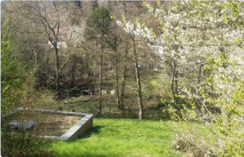
Flächen von Anlagen pflegen wir extensiv. Hier die Trinkwasseranlage Schmitt'sche Quelle im Heidelberger Mühlthal.
