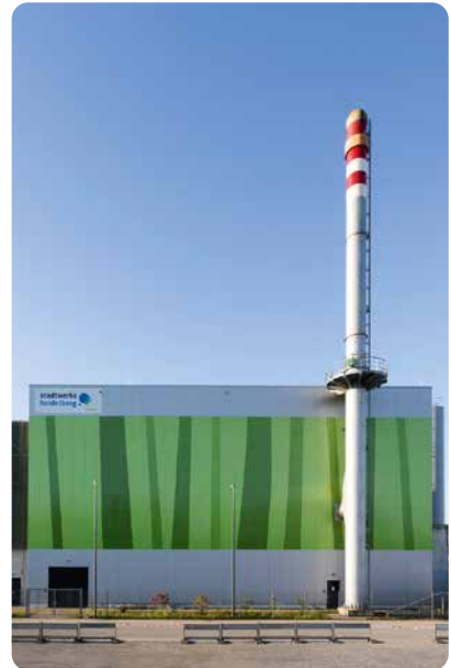
Das Holz-Heizkraftwerk in Heidelberg-Pfaffengrund aus der ersten Dekade unserer Energiekonzeption, der Energiekonzeption 2020 .
