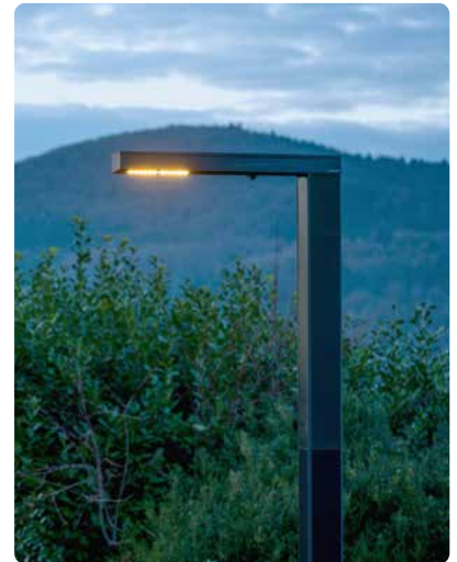
Neue Solarleuchte im Außenbereich an der Zufahrt zu einem alleinstehenden Haus.
