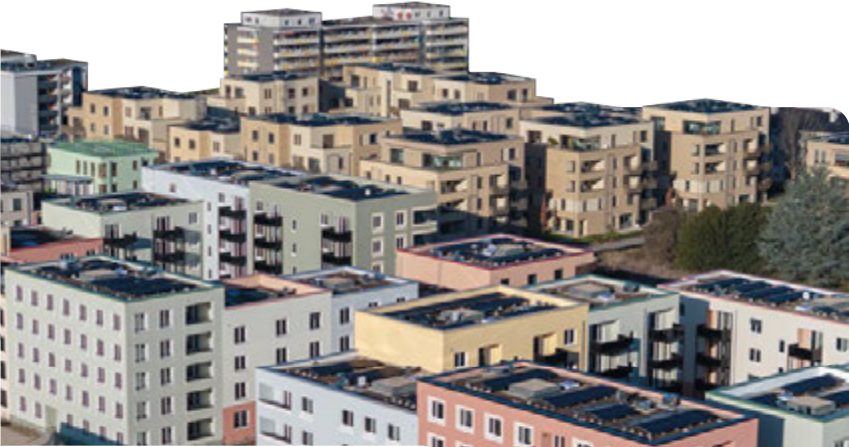
Im Hospital-Quartier in Heidelberg-Rohrbach liefern Photovoltaik-Anlagen direkt vor Ort erzeugte Energie an die Mieterinnen und Mieter.
