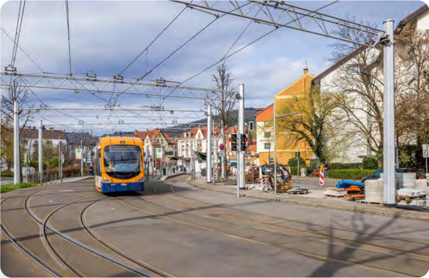
Am Hans-Thoma-Platz in Heidelberg-Handschuhsheim wurden 2022 Gleise und Weichen saniert.
