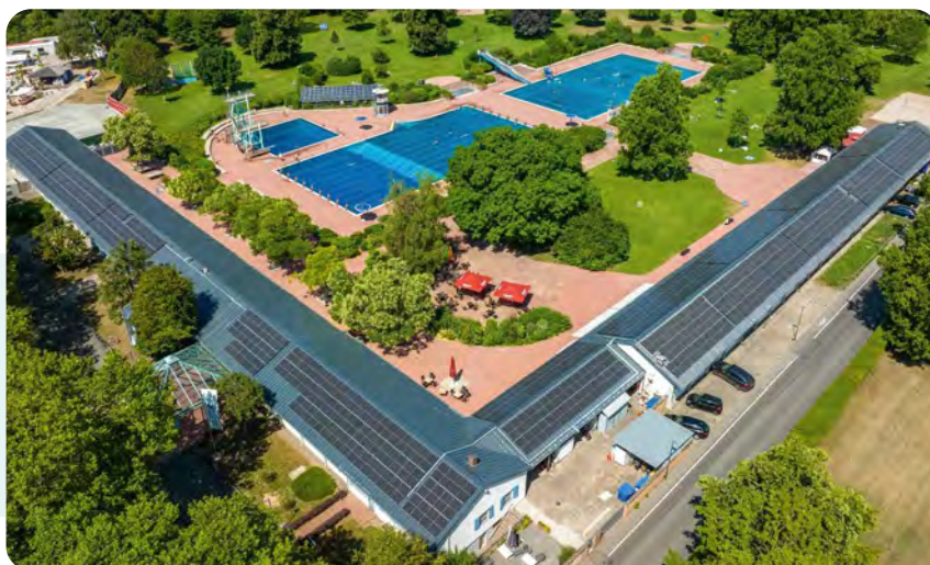
Unsere größte neue PV-Anlage haben wir 2022 im Tiergartenbad in Betrieb genommen.
