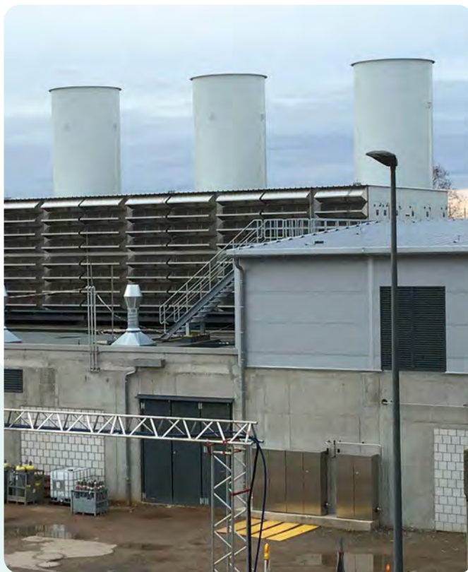
Baustand der iKWK-Anlagen gegen Ende des Jahres 2022.
