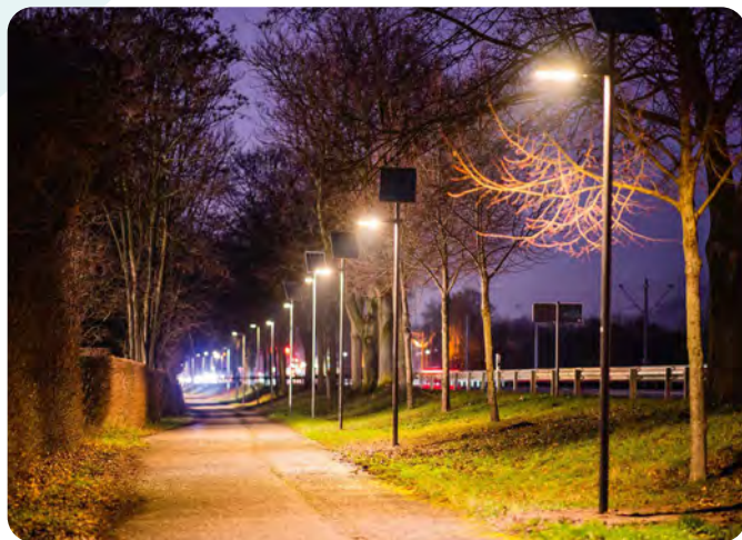
Die Solarteststrecke am Fahrradweg in Heidelberg-Rohrbach-Süd.
