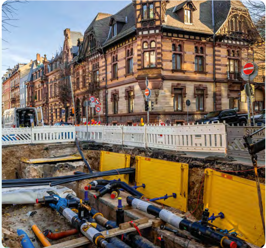
Baustelle Rohrbacher Straße: Die Maßnahme an der zentralen Verkehrsachse liegt trotz schwieriger Bedingungen an den Märkten für Baudienstleistungen und -materialien gut im Plan und wird voraussichtlich sogar um zwei bis drei Monate früher fertig.
