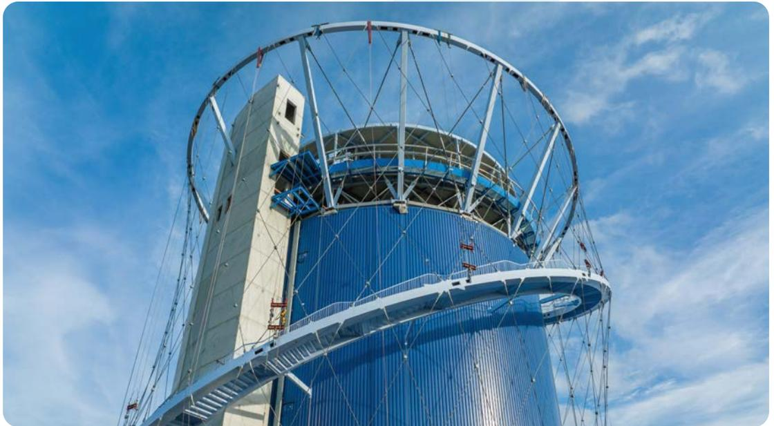
Im Sommer 2022 wurden das Seilnetz und die helixförmige Treppe um den Energie- und Zukunftsspeicher montiert.
