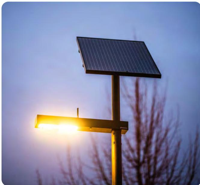
Als besonders effizient und leistungsstark haben sich Solarleuchten erwiesen, bei denen die Solarpanels und die Akkus extern angebracht sind.
